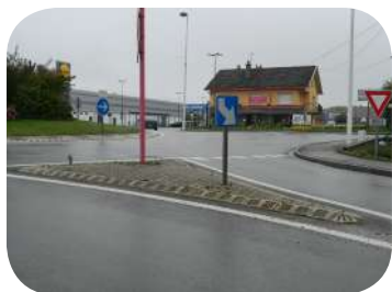
Diviseur de voirie minéral avec bordure - Neufchâteau (88)
