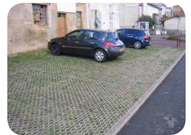
Parking en dalles alvéolées à Doncourt-lès-Conflans (54)
