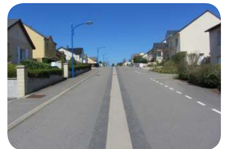
Caniveau central - Pont-à-Mousson (54)
